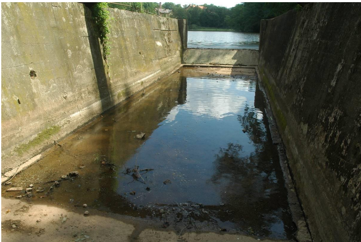
Foto č. 3. Bezpečnostní přeliv u levého zavázání hráze.
